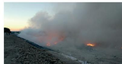
Incendie sur l'ISDND de Nicole (6 000 m<sup>2</sup>), site fermé 2 jours, 800 m<sup>2</sup> d'étanchéité détruits ainsi que les compacteurs. Travaux d'urgence réalisés en un mois, pris en charge par l'assurance
