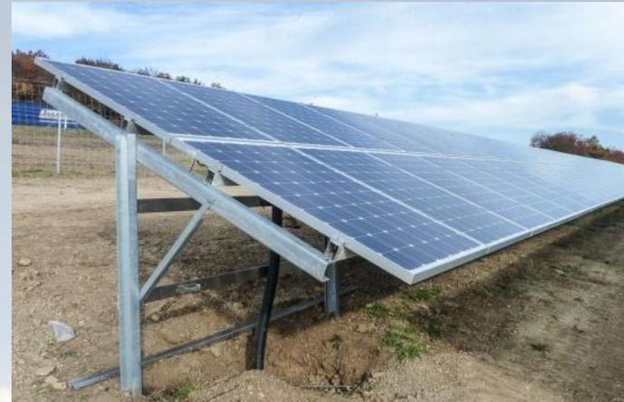
Structure avec ancrage par pieu sur la zone hors casiers
