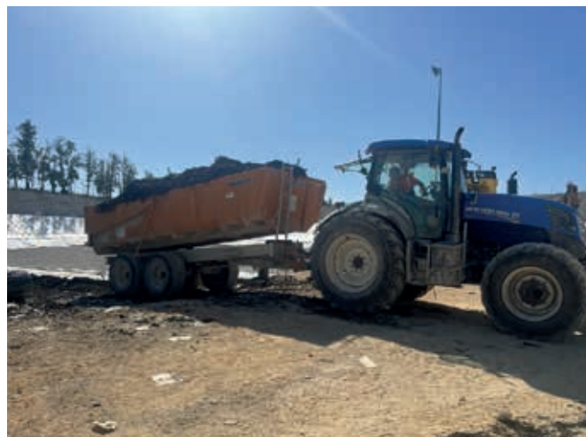
Recouvrement des casiers de déchets avec du refus de criblage de végétaux afin de limiter les odeurs
