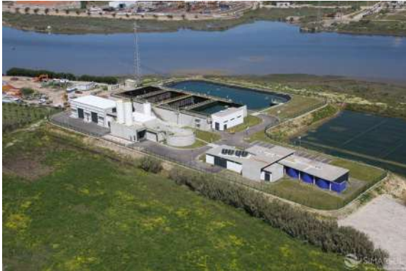
FCT/Nova : Station d'épuration en bord du Tage, provenance des effluents analysés dans le cadre du projet CEMOWAS2
