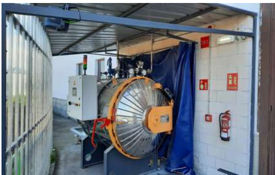
CSIC : Installation pilote du traitement HTC mise en place sur le site de Cogersa
