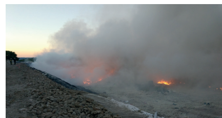
Incendie sur l'ISDND de Nicole (6 000 m²), site fermé 2 jours, 800 m² d'étanchéité détruits ainsi que les compacteurs. Travaux d'urgence réalisés en un mois, pris en charge par l'assurance
