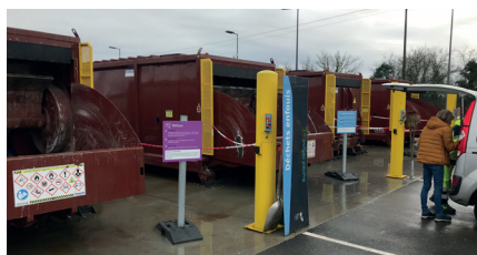
Nouvelle déchetterie de Miramont-de-Guyenne : nouveau marché de traitement pour ValOrizon
