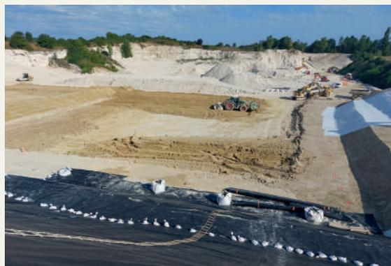
Mise en place de la couche d'argile (BSP) et de la géomembrane (BSA)
