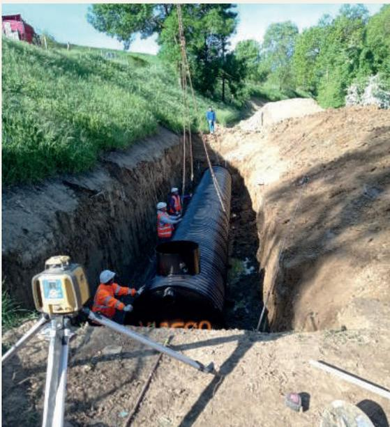
Une cuve enterrée de 30m<sup>3</sup> a été installée pour le stockage des lixiviats jusqu'à leur traitement.
