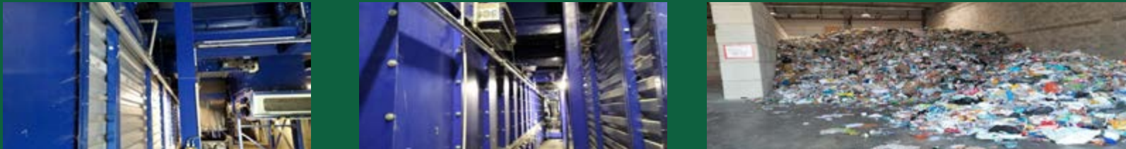
Travaux centre de tri : création du stock amont 3.
