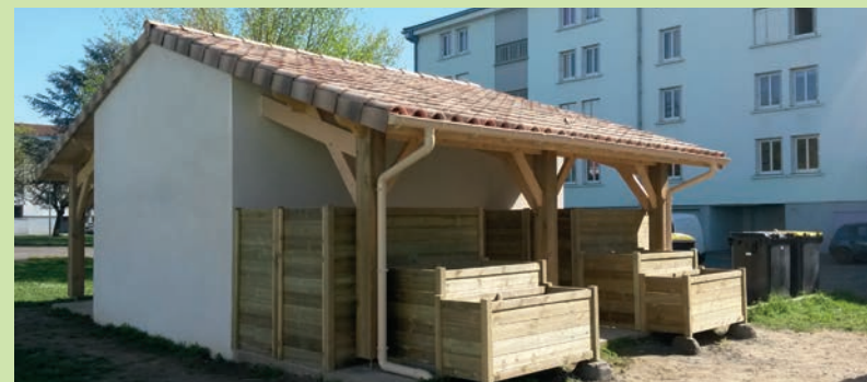
Pavillon de compostage du quartier de La Gravette à Marmande
