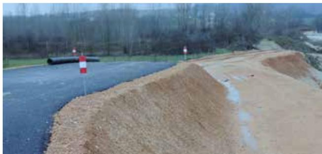
Réalisation du nouveau quai de vidage, de la voirie d'accès et sécurisation du quai. Travaux sur l'étanchéité, le captage biogaz et la couverture de l'alvéole A
