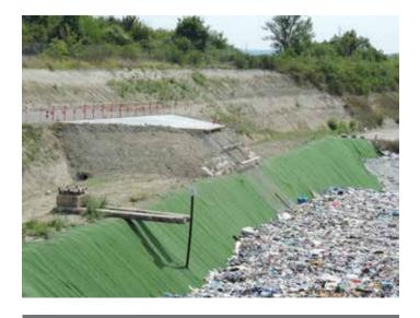
Condamnation du piézomètre Pz3 (situé à l'extérieur à l'origine et rattrapé par l'extension du casier) et création d'un piézomètre de remplacement.
