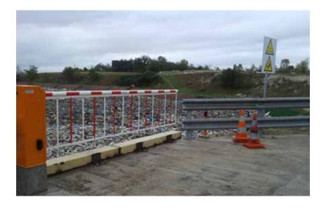
Réalisation d'un nouveau quai de vidage avec un système de sécurisation (barrière commandée à distance par le conducteur du compacteur).
